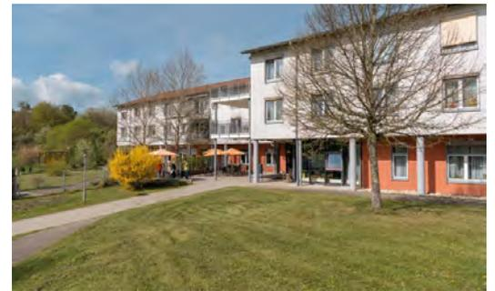
Massivbauweise, innen teilweise mit Leichtbauwänden, Windfang, Wärmeschutzverglasung
