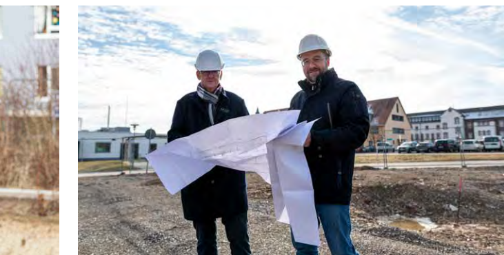
Rainer Dilger (li.) und Michael Wühr (re.) auf dem Bauplatz von Haus Laura, einer Einrichtung für Betreutes Wohnen. Kontinuierlich steigende Kosten im Bausektor erschweren Kalkulation und Planung solcher Projekte zunehmend.
